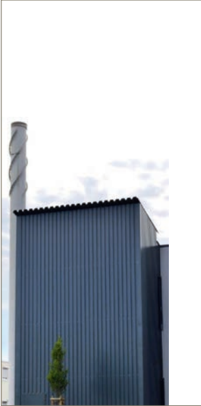
Abb. 35: Beispiel eines eingehausten Pelletsilos zur Außenanstellung
