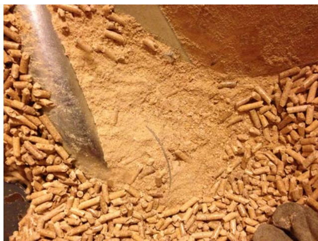
Abb. 34: Ein durch Feinanteile blockiertes Fördersystem.
