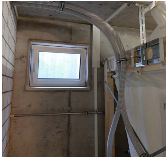
Abb. 16: Belüftungslösung für luftdurchlässige Gewebesilos ohne Absaugstutzen in einem Aufstellraum mit nach aussen geführten Stutzen
